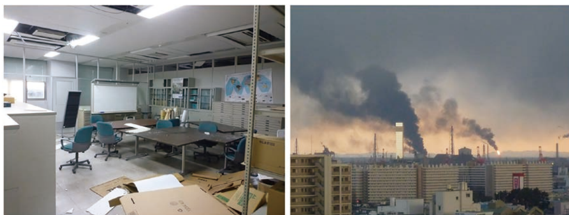
図1.4 総合研究棟8階の天井板の落下と臨海部コンビナートからの黒煙
