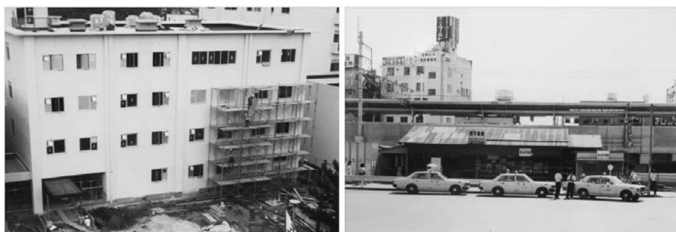
図2.5 昭和56年の竣工直前の研究棟と、当時の西千葉駅前の写真
