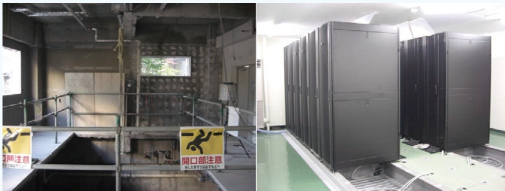
写真2：CEReS 1階サーバ室設置の様子。（左）重量負荷に耐えうる構造物を入れるため床に穴を開けた状態。（右）サーバラック群設置直後の様子
